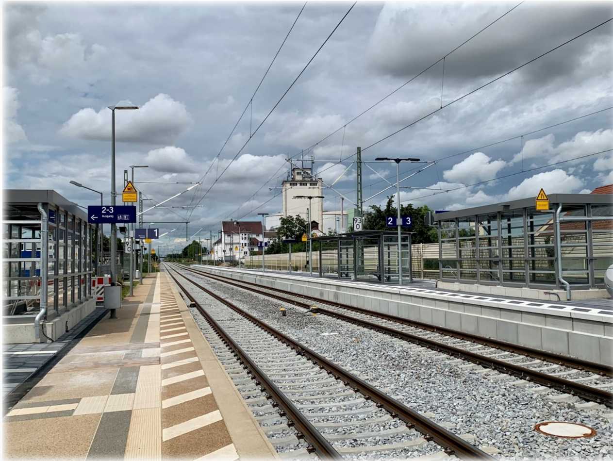
Bahnlinie Regensburg-Passau, Bahnhof barrierefrei
