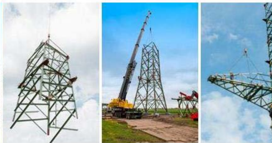
Abbildung 19 20: Mastmontage mittels Mobilkran
