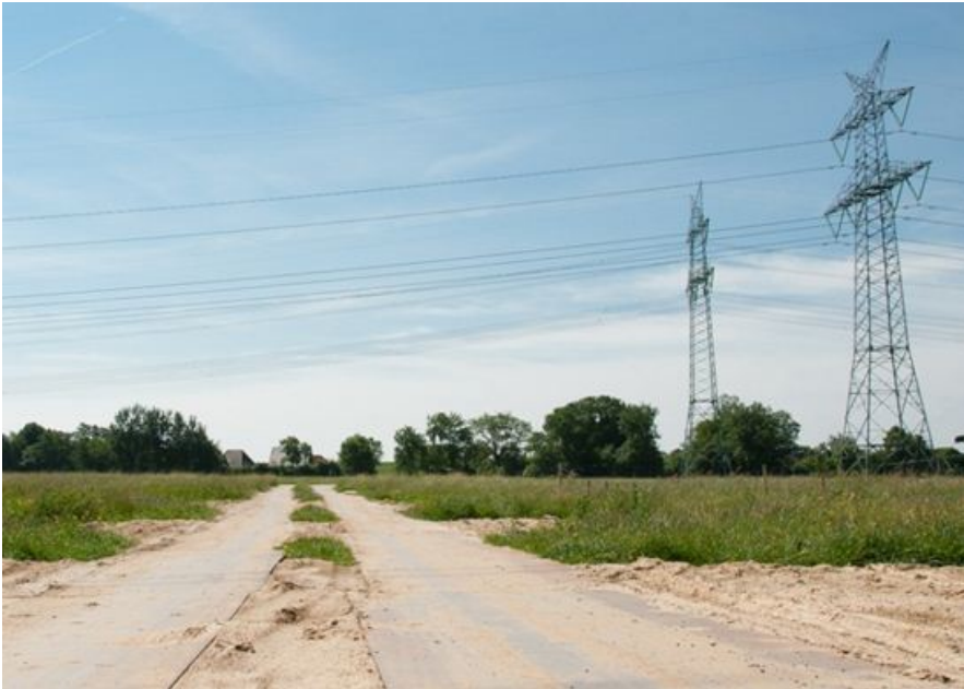
Abbildung 45 16: Beispiel für eine temporäre Mastzufahrt
