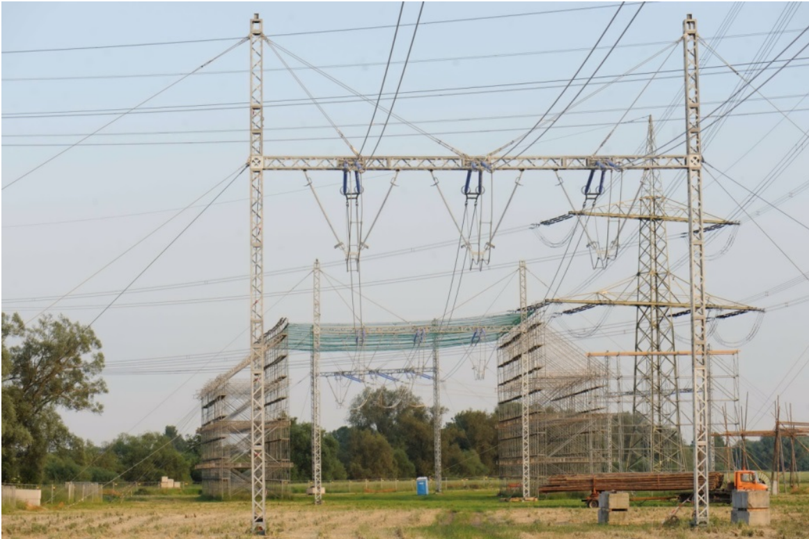
Abbildung 43 14: 380-kV-Freileitungsprovisorium für ein System mit errichtetem Schutzgerüst
