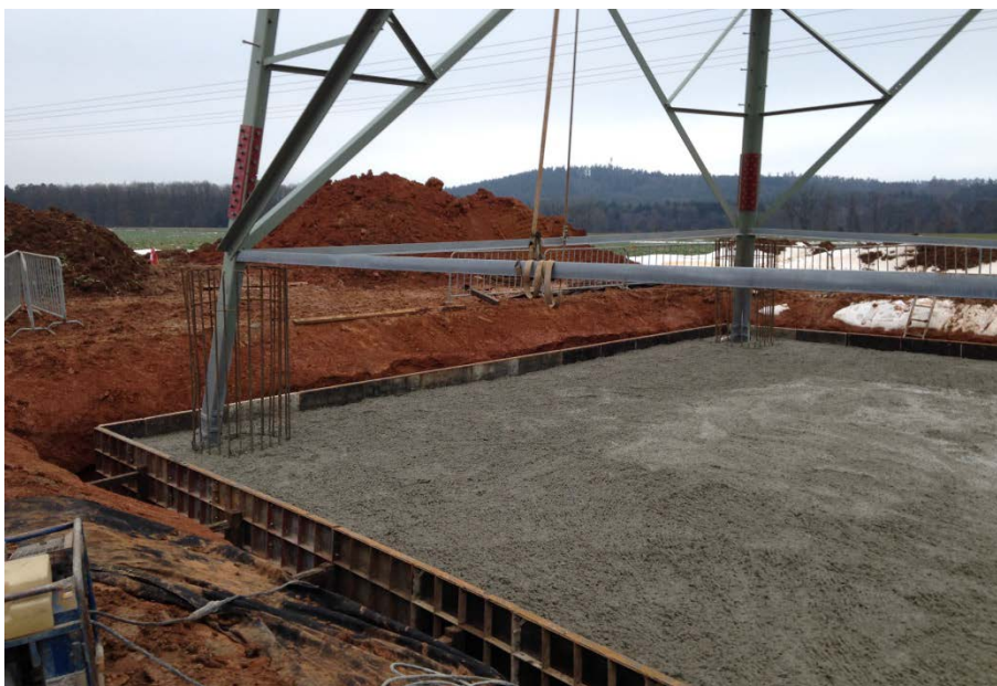
Abbildung 18 19: Plattenfundament
