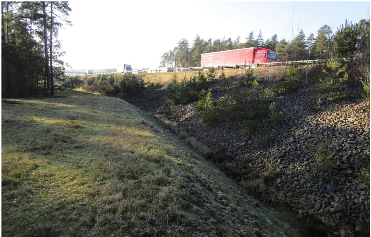
Bild 2: technischer Graben zur Ableitung des Wassers aus dem RHB 54-1R
