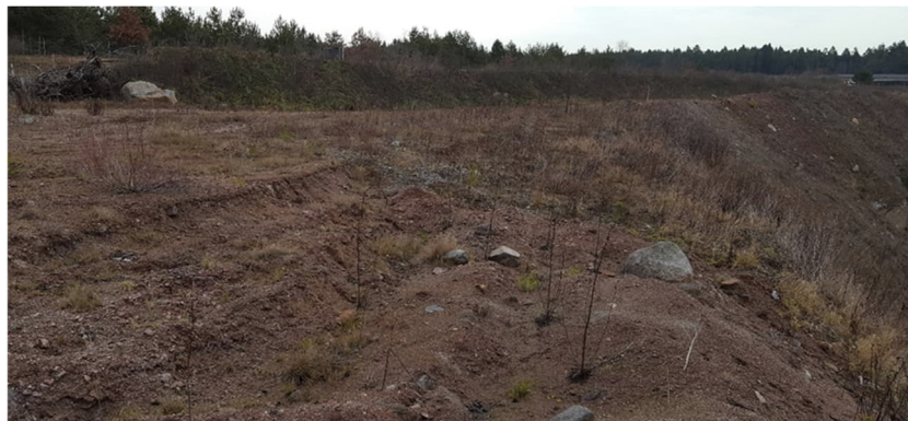
Abbildung 2: Kleine Abrisskante durch Setzung im aufgeschütteten/angeschütteten Material
