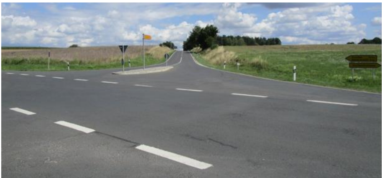
Bild 19: Kreuzung St 2120 / NEW 43 am nördlichen Ortseingang von Kirchenthumbach
