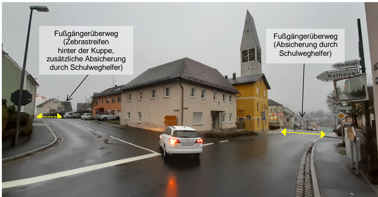
Bild 26: Übereckverbindung der St 2120 in der Ortsdurchfahrt; vorhandene Fußgängerquerungen
