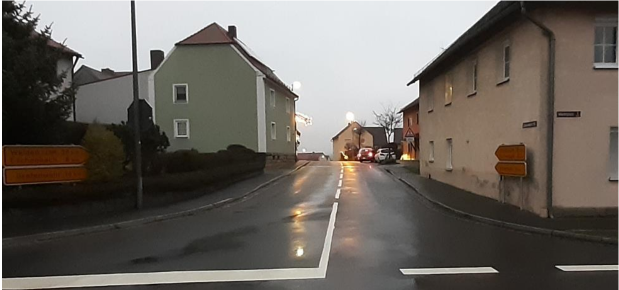
Bild 24: schwer erkennbare Schulwegquerung (Zebrastreifen) hinter eng ausgerundeter Kuppe
