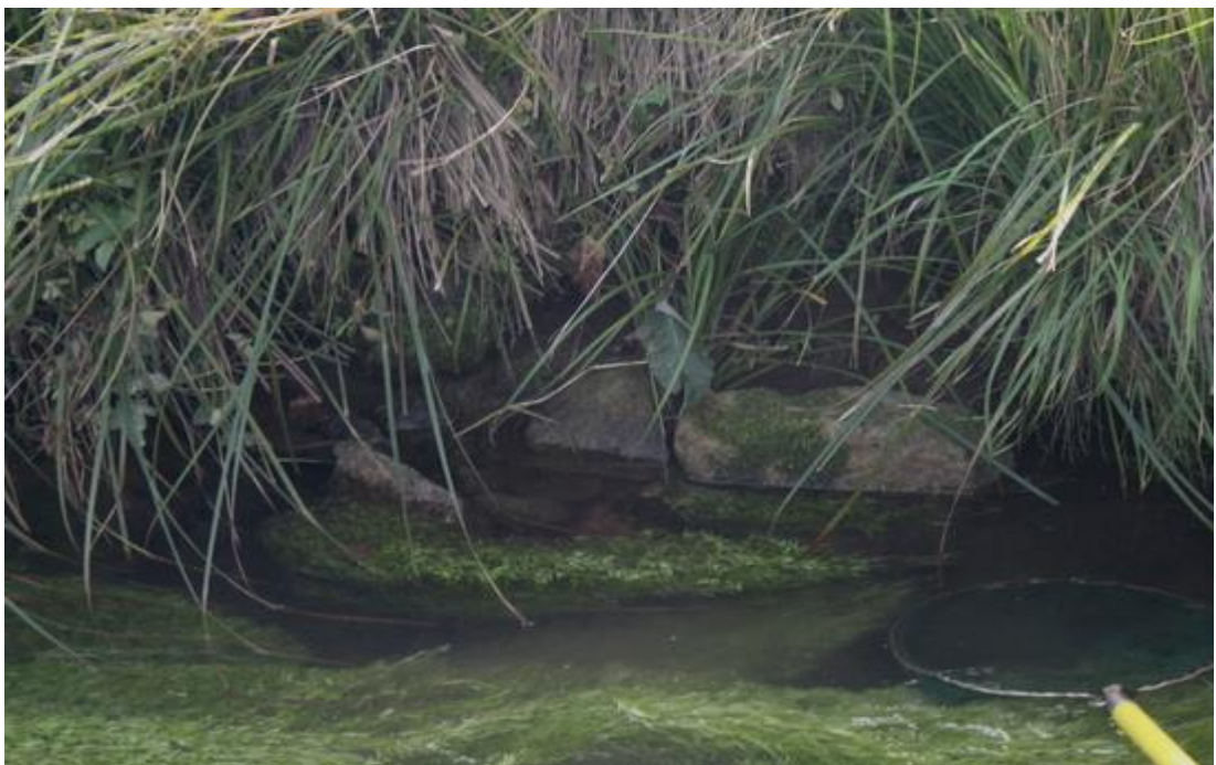
Abb. 8: Ufer- und Sohlenbefestigung am Loisbach (Foto: Ring, 13.09.2011)
