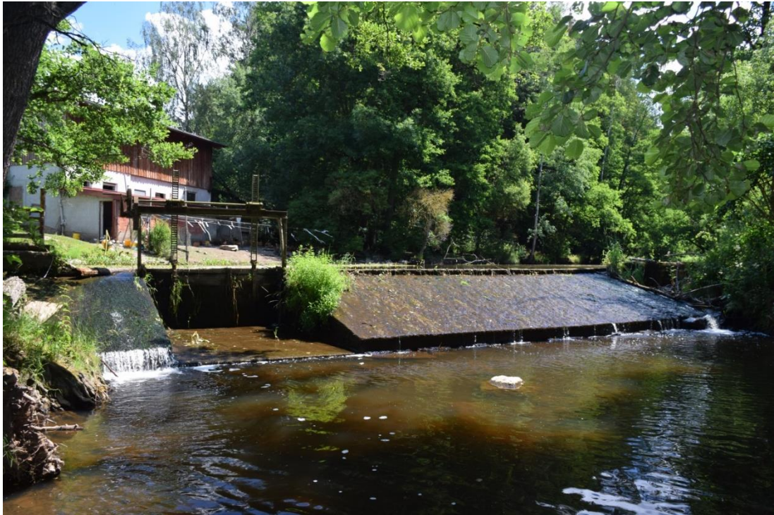
Abb. 14: Wehr an der Finstermühle ohne Fischwanderhilfe (Foto: Harrantdt)
